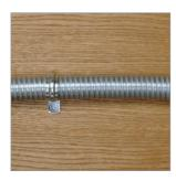
Благодаря тому, что металлорукав изготовлен из несгораемого материала, его можно применять при прокладке проводки по сгораемым поверхностям.
