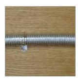
Благодаря тому, что металлорукав изготовлен из несгораемого материала, его можно применять при прокладке проводки по сгораемым поверхностям.
