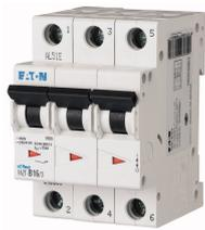
**Автоматический выключатель 16А, кривая отключения C, 3 полюса, откл. способность 25 кА**
